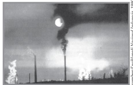
*Gambar 1.4.6 Pencemaran udara oleh pembakaran sisa gas alam lazim melepaskan belerang dioksida ( $\text{SO}_2$ ) dan karbon dioksida ( $\text{CO}_2$ ) sebagai zat pencemar udara.*
