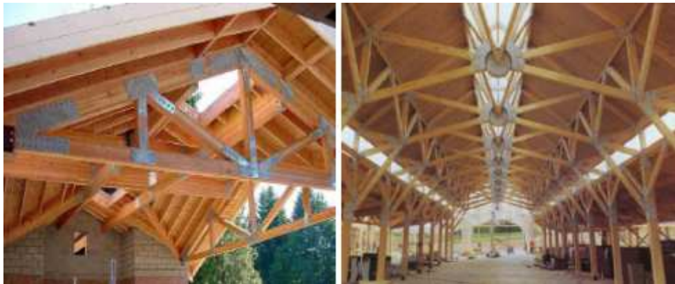
Gambar 8.35: Contoh struktur rangka batang kayu dengan plat sambung
