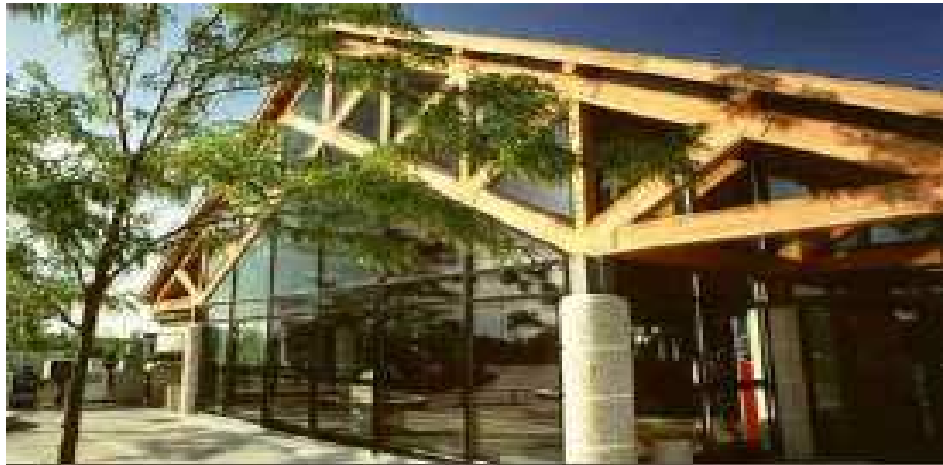
Gambar 8.34: Contoh penggunaan struktur rangka batang kayu
