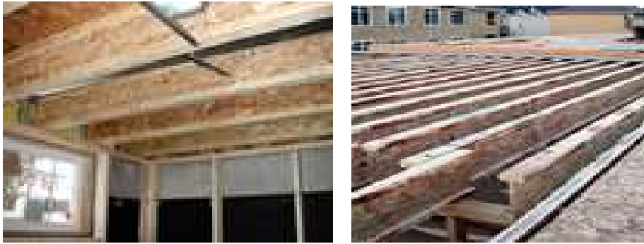
Gambar 8.27: struktur balok I dari produk kayu buatan
