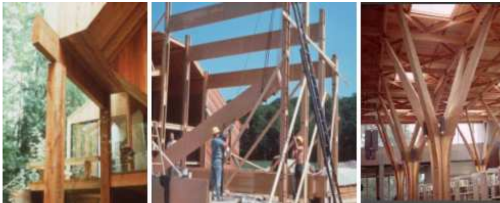
Gambar 8.24: Kolom tunggal, kolom ganda dan produk kolom laminasi
