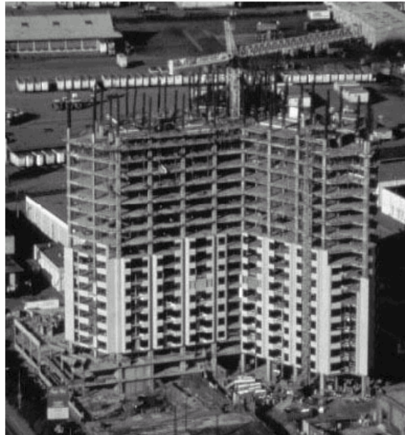
Gambar 7.1. Bangunan struktur beton
