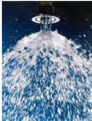
**Gambar 105. Sprinkler akan menyemprotkan air secara otomatis**
