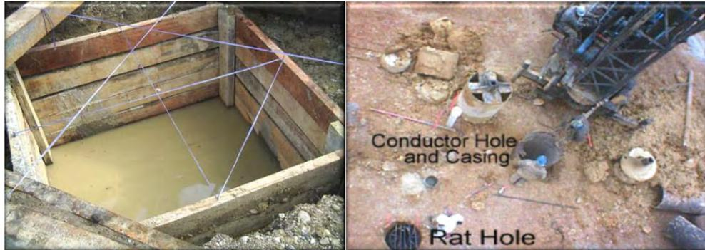
Gambar 2.5. Pembuatan Cellar dan Pemasangan Conductor Pipe
