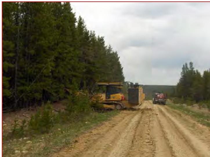
Gambar 2.2. Pembuatan jalan ke Lokasi Pemboran
