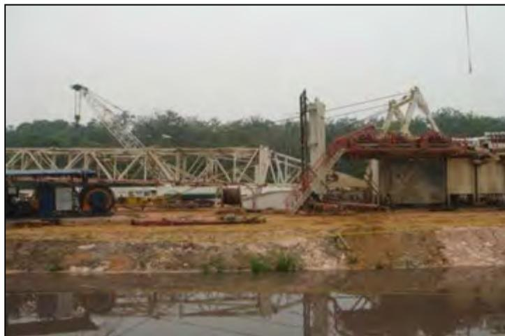
Gambar 2.11. Dasar dari *Mast* Diangkat ke *Rig Floor*
