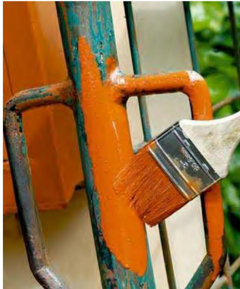
**Gambar 99. Pengecatan pada logam (sumber : google.com)**
