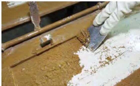
Untuk cat oven (stoving enamel) membutuhkan waktu yang lama untuk mengeriputkan
