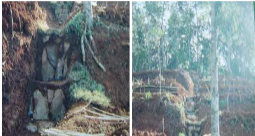
**Gambar 78. Bangunan Saluran Pembuang Air (SPA) dari batu.**
