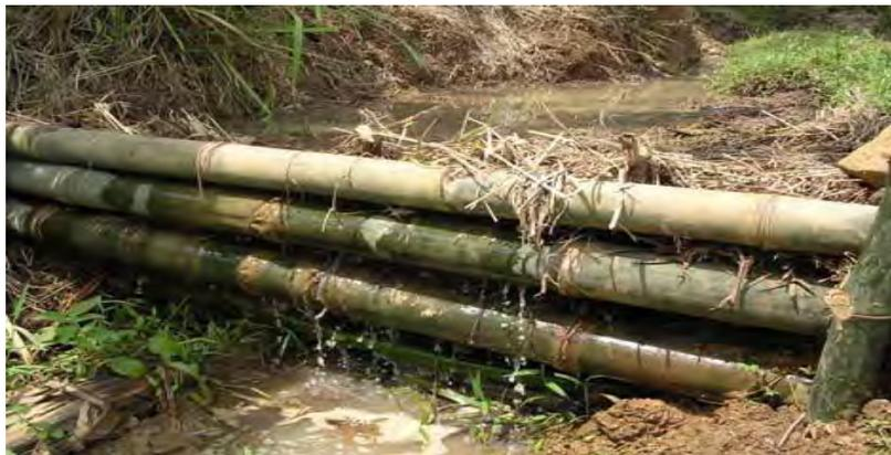
**Gambar 79. Bangunan terjunan air (BTA) dari bambu**
