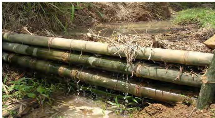
**Gambar 43. Bangunan terjunan air (BTA) dari bambu**
