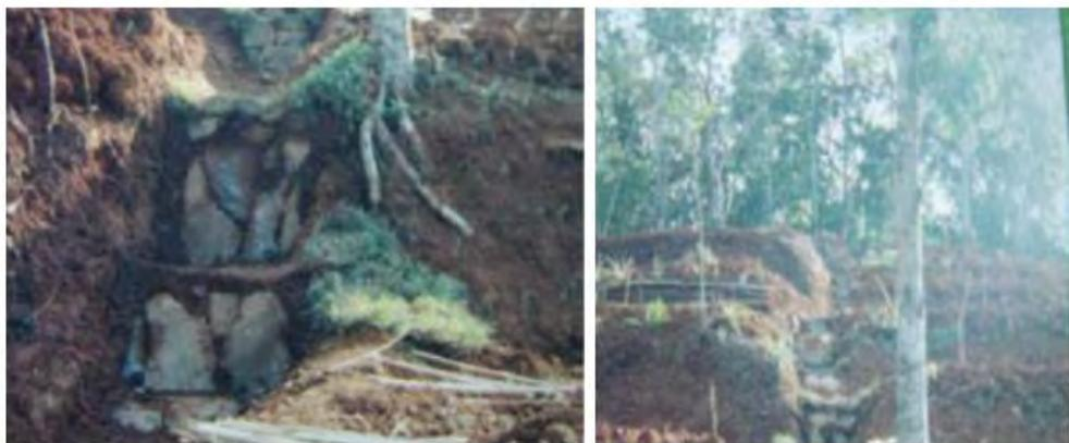
**Gambar 42. Bangunan Saluran Pembuang Air (SPA) dari batu**
