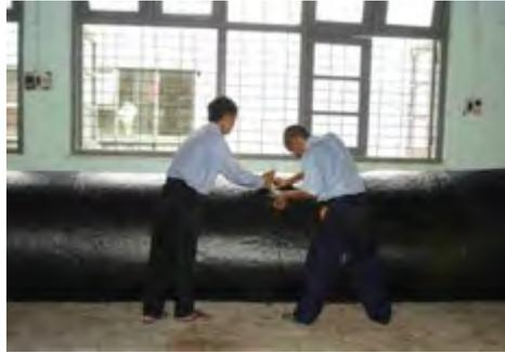
Gambar 36. Menyambung tabung reaktor
