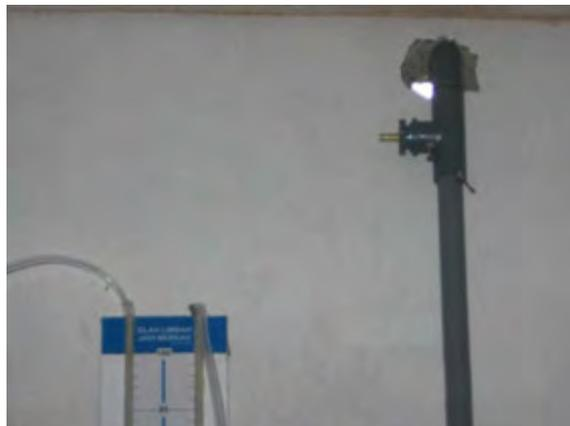
Gambar 161. Pemasangan *nipple* pada *fitting* T
