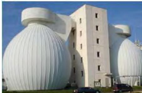
Gambar 13. Contoh Reaktor Biogas (Jepang)
