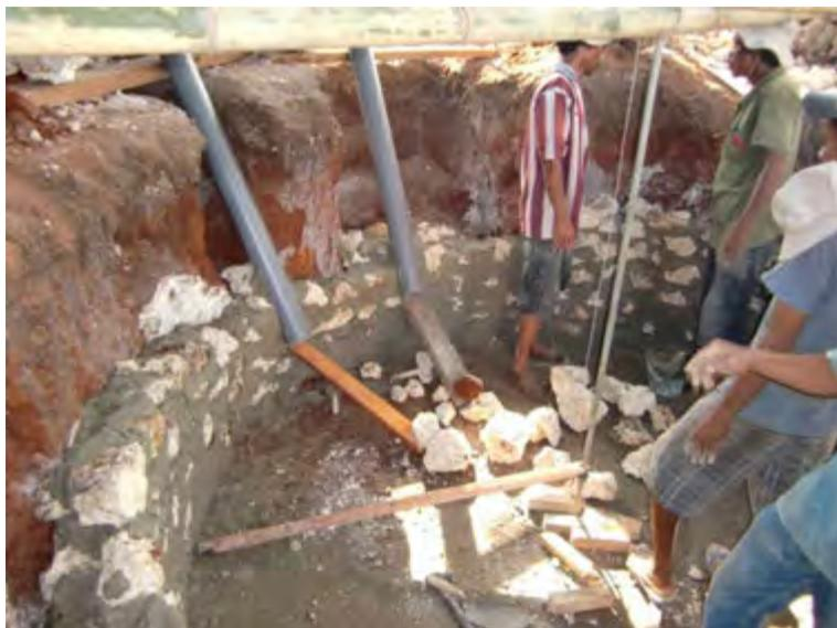
Gambar 78. Pemasangan pipa *Inlet*
