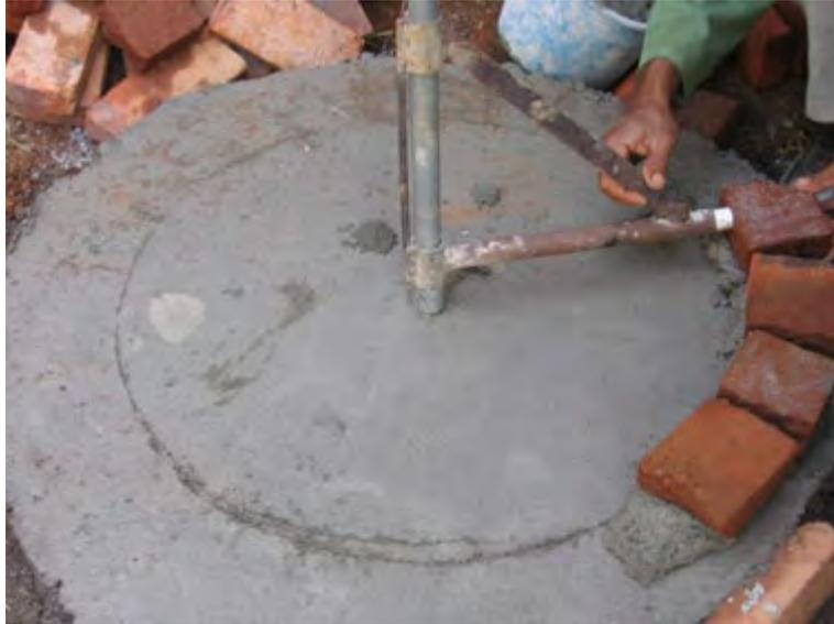
Gambar 128. Menggambar *lay out inlet* di atas pondasi
