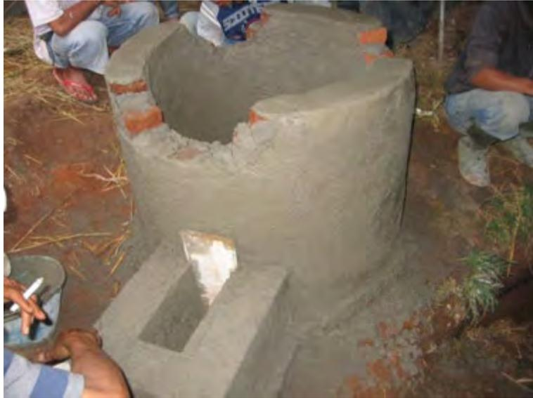
Gambar 132. Pekerjaan *finishing inlet*
