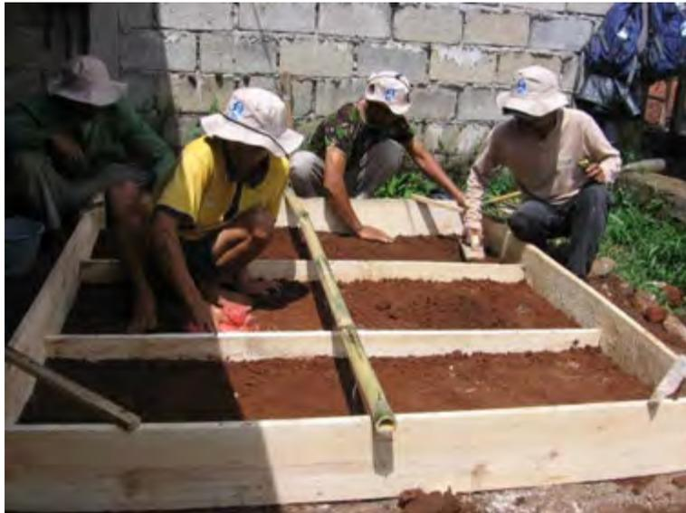
Gambar 99. Memasang bekisting plat penutup *Outlet*
