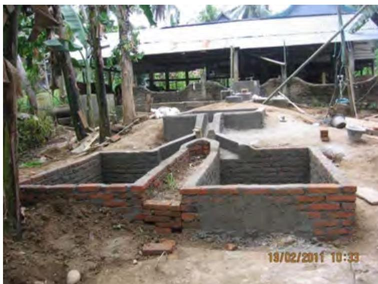
Gambar 153. Contoh *slurry pit* dari pasangan bata
