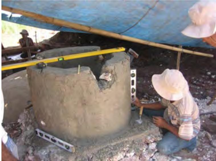
Gambar 138. Melakukan *finishing inlet* sebelum pemasangan *mixer*
