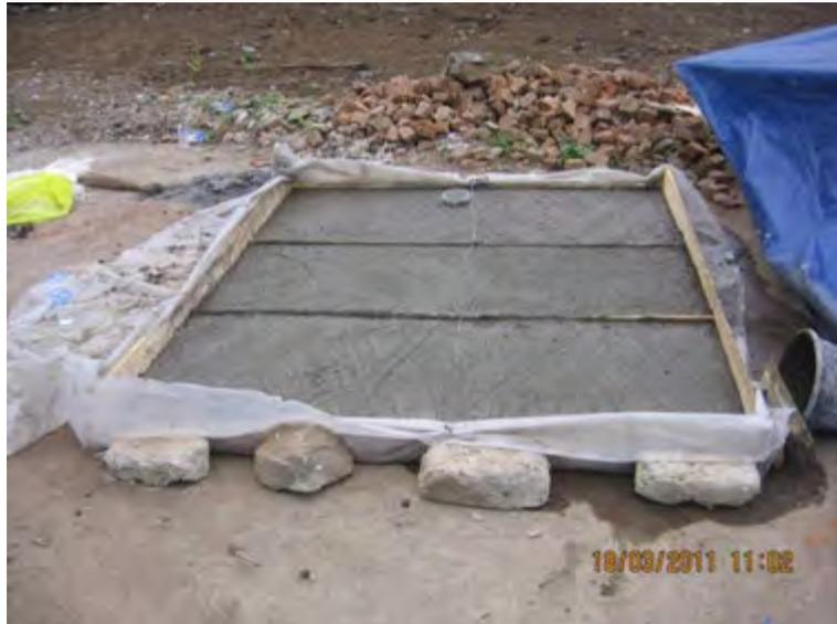
Gambar 103. Plat penutup *Outlet* setelah selesai dicor
