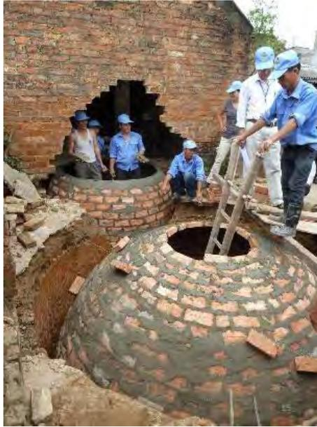
Gambar 22. Pembangunan reaktor biogas (Vietnam)
