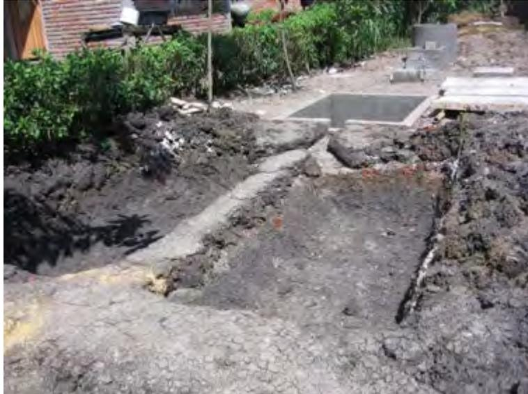
Gambar 151. Contoh lubang kompos tanpa pasangan
