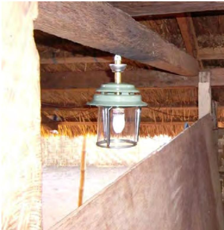
Gambar 171. Contoh lampu biogas di Sumba Barat Daya
