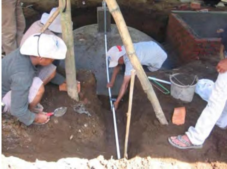
Gambar 144. Penggalan tanah untuk kotak *water drain*
