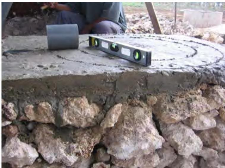
Gambar 135. Menggambar *lay out inlet*
