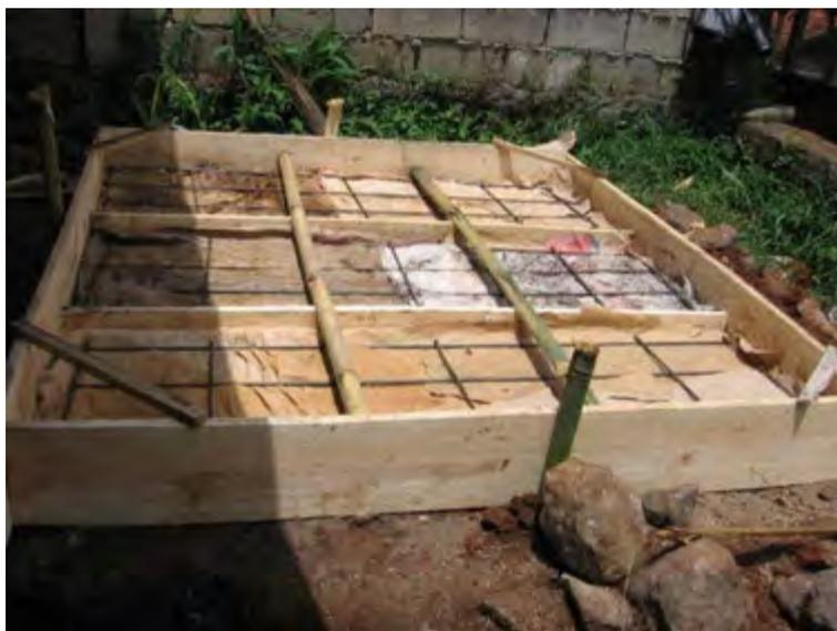
Gambar 101. Memasang besi tulangan plat penutup Outlet
