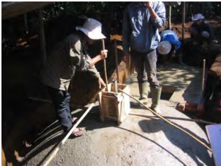
Gambar 110. Pemasangan bekisting turet dari beton
