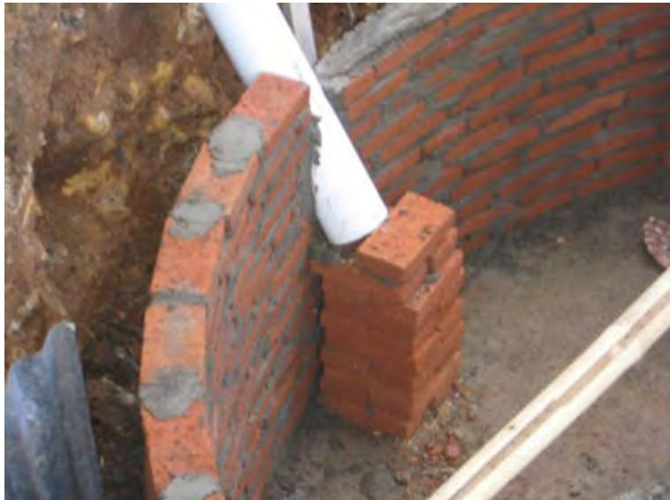
Gambar 64. Penyesuaian ketinggian pipa *Inlet* dari pondasi
