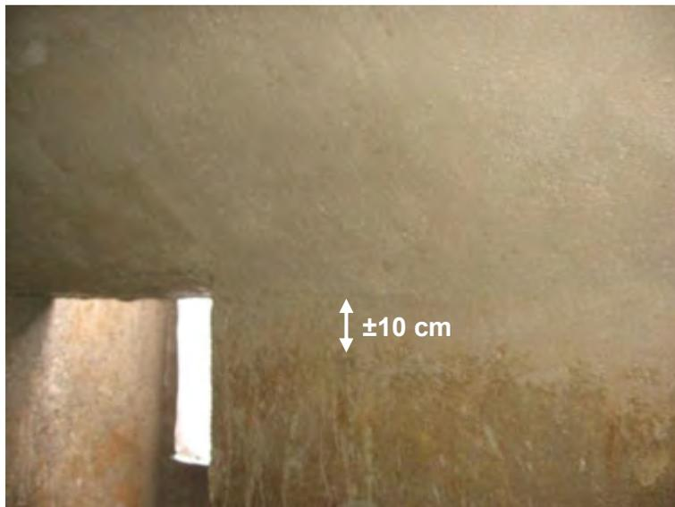
Gambar 172. *Finishing* lapisan ke 1
