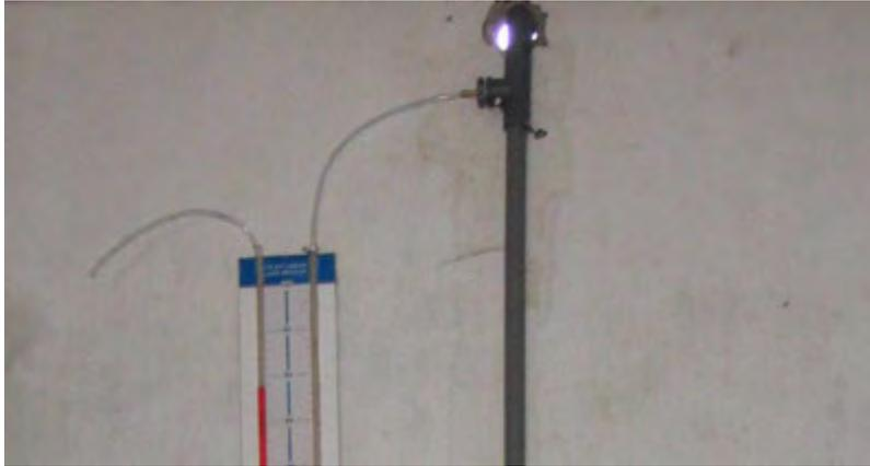
Gambar 162. Menghubungkan manometer dengan *nipple*
