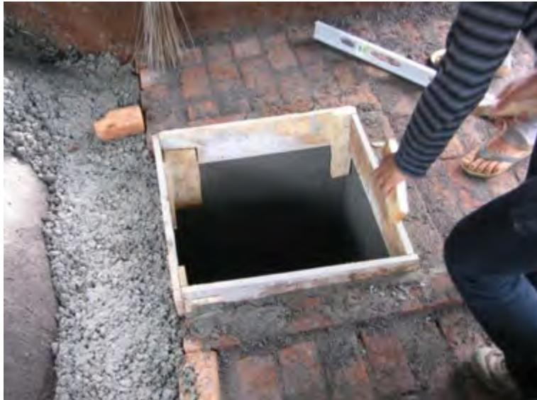
Gambar 114. Memasang bekisting untuk *manhole*
