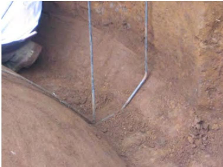
Gambar 86. Pembentukan tepi kubah dengan mal
