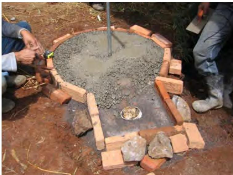
Gambar 127. Mengecor lantai dasar *inlet*
