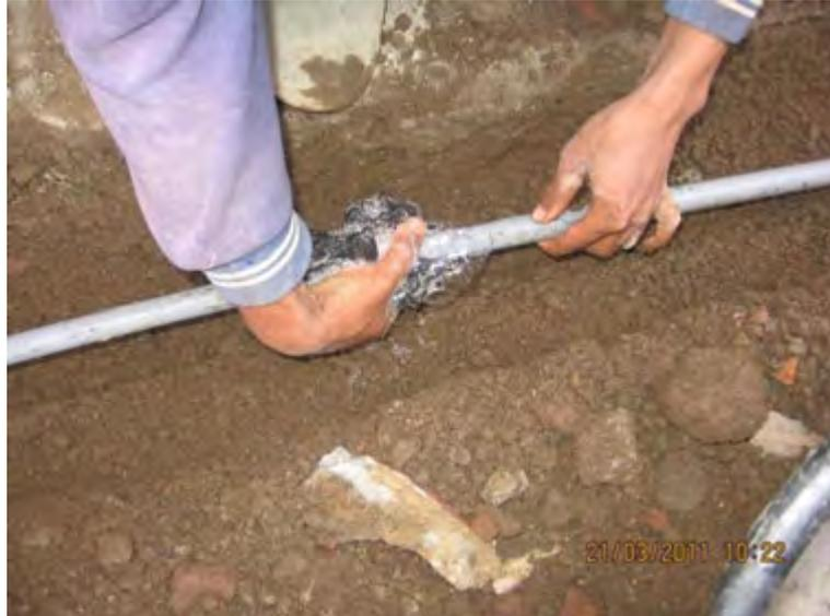
Gambar 166. Cara memeriksa kebocoran pipa pada sambungan
