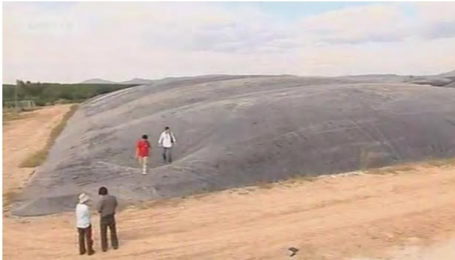
Gambar 10. Penutup kolam penampungan biogas dari plastik
