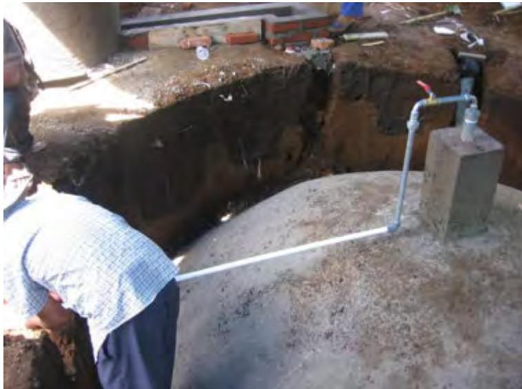
Gambar 143. Pemasangan pipa PVC yang menuju ke dapur
