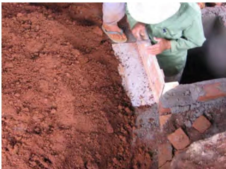
Gambar 84. Pemasangan bekisting untuk balok kubah
