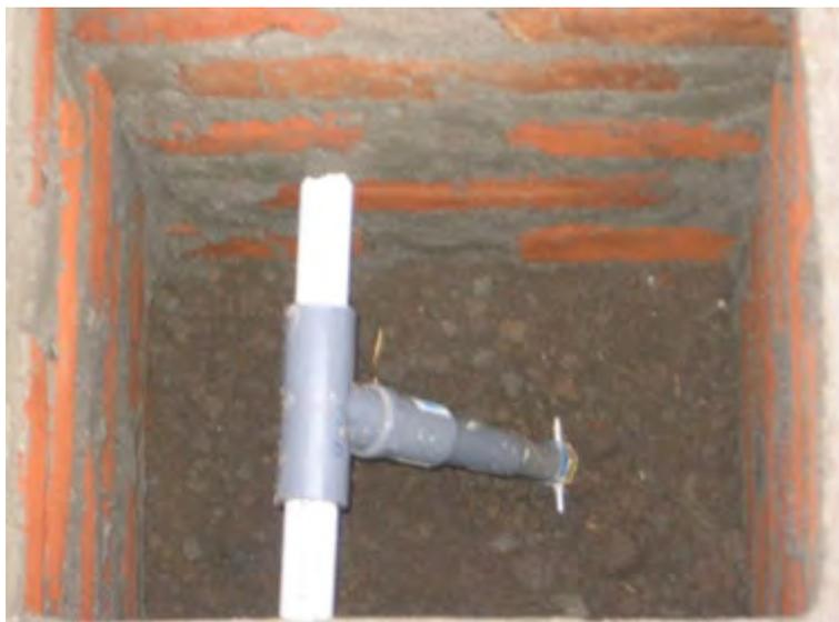
Gambar 146. *Water drain* harus dipasang dengan posisi miring
