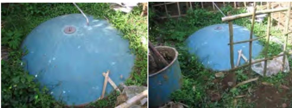
Gambar 29. Reaktor biogas dari bahan fiberglass
