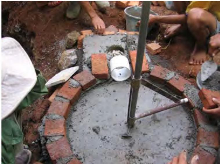
Gambar 129. Memasang bata dan pipa saluran
