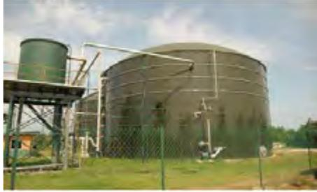
Gambar 15. Contoh reaktor biogas (Jerman)
