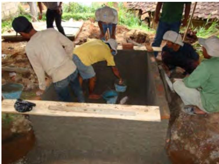
Gambar 119. Pekerjaan pemlesteran dinding *Outlet*
