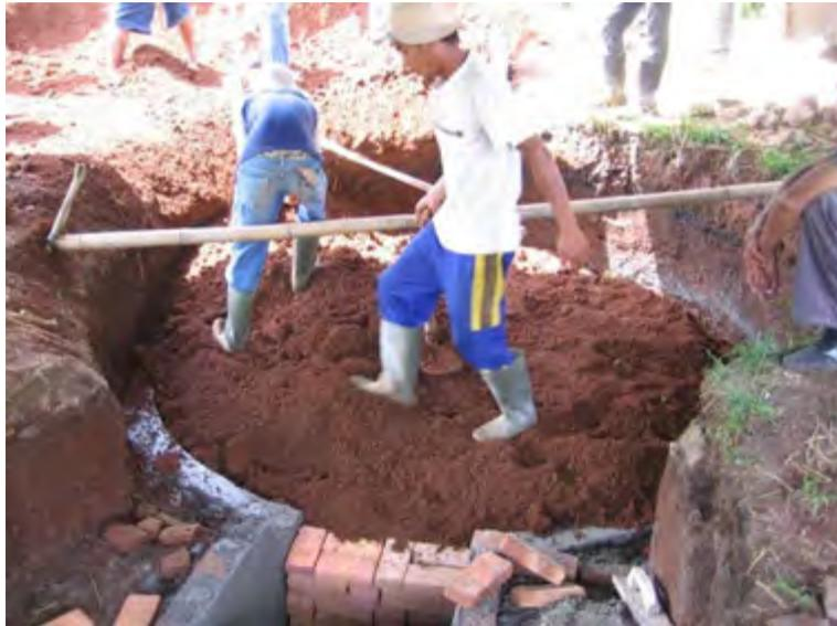
Gambar 83. Pemasangan tanah lapis demi lapis
