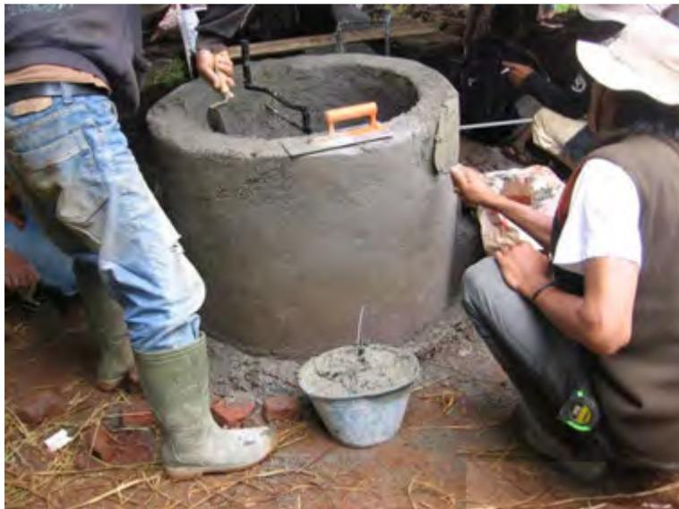
Gambar 133. Pemasangan *mixer* dan *finishing* kembali inlet
