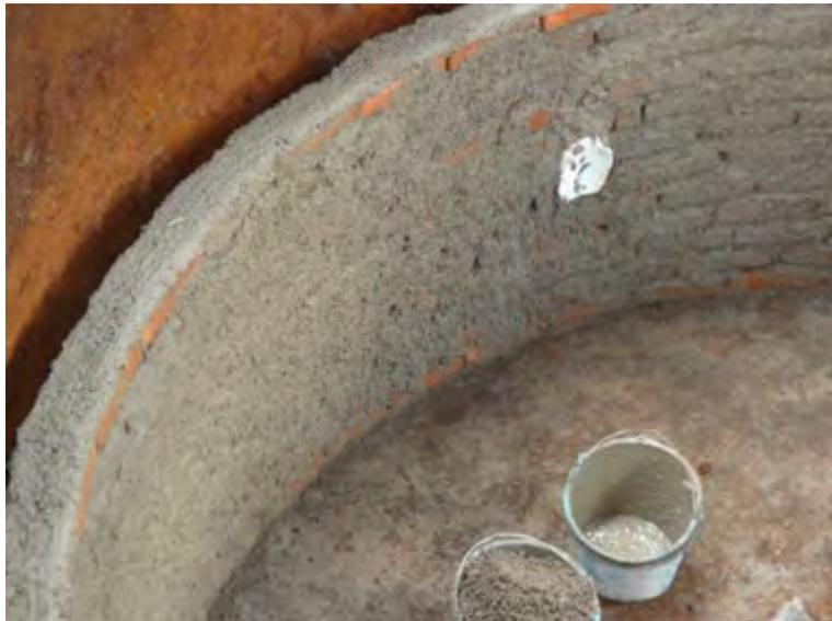
Gambar 66. Pengkamprotan dinding tangki pencerna
