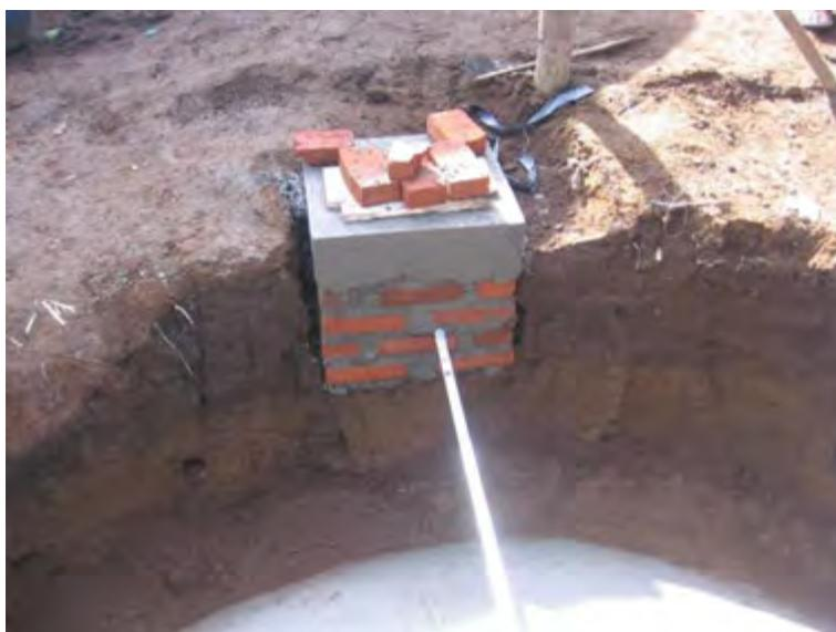
Gambar 147. Kotak *water drain* yang dipasang dekat reaktor biogas
