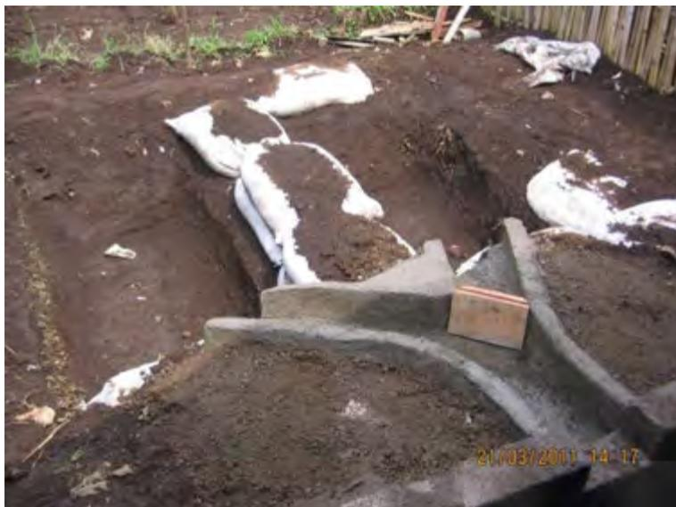
Gambar 152. Lubang kompos dari tanah dengan saluran pasangan
