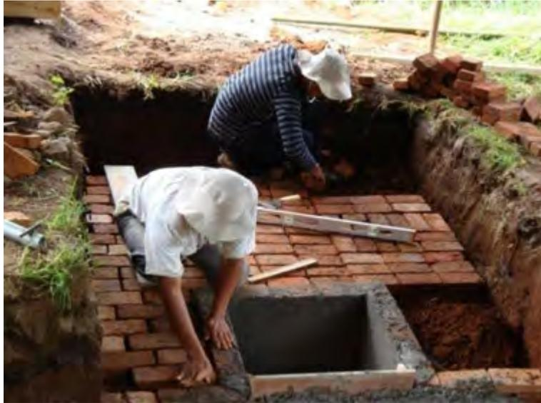
Gambar 112. Menyusun bata untuk lantai kerja
