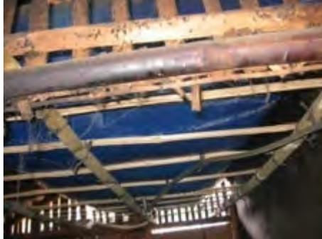
Gambar 38. Kantung biogas di plafon rumah
