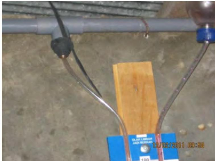
Gambar 168. Mengatasi kebocoran pada nipple untuk sementara
