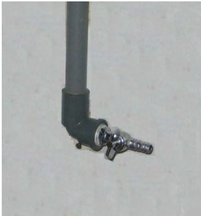
Gambar 163. Pemasangan kran gas
