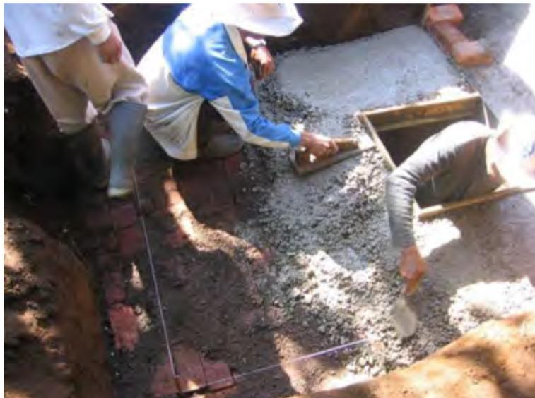
Gambar 115. Pengecoran lantai *Outlet*
