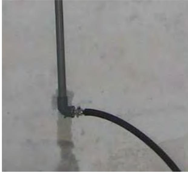
Gambar 164. Menghubungkan keran gas dengan kompor
