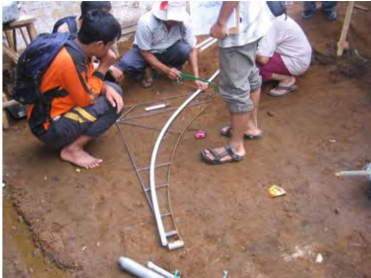
Gambar 89. Menyiapkan mal besi sebagai acuan pengecoran
