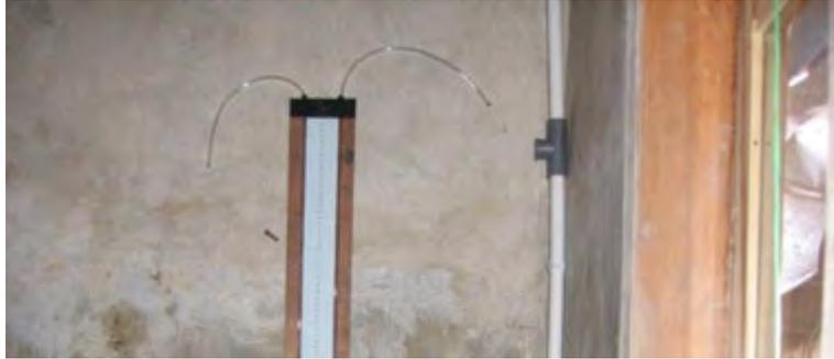
Gambar 159. Pemasangan *fitting* T sebelum ujung akhir pipa
