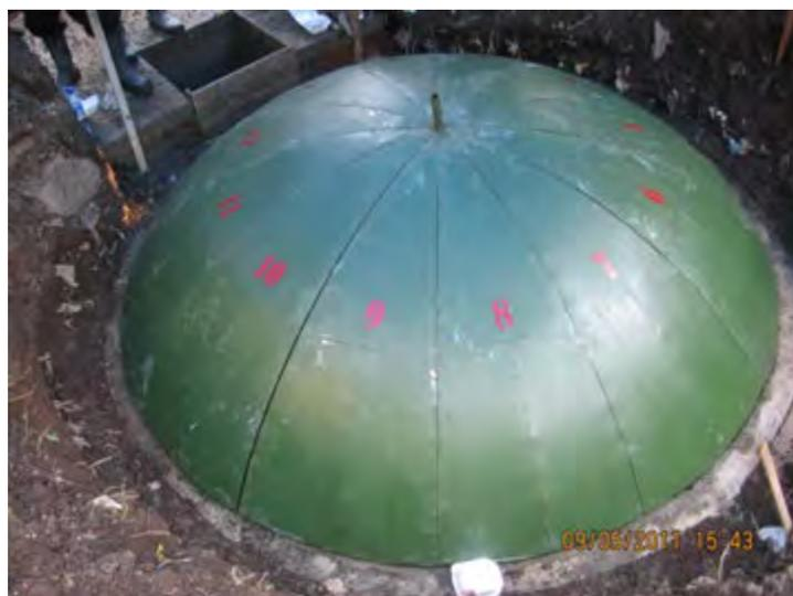
Gambar 80. Contoh cetakan kubah dari plat besi (2)
