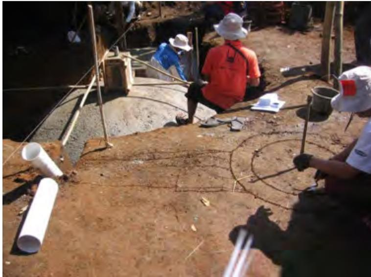
Gambar 124. Menggambar lay out inlet di atas tanah
