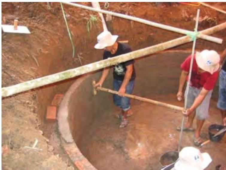
Gambar 73. Contoh mal dari bambu
