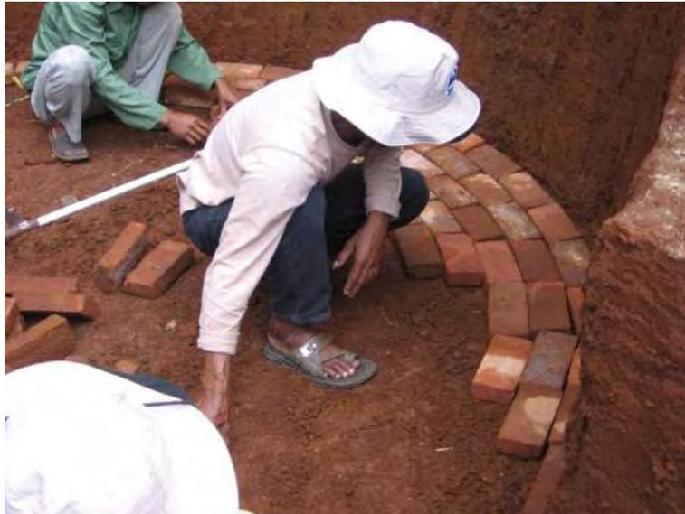
Gambar 47. Menyusun bata untuk lantai kerja
