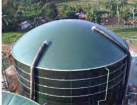
Gambar 16. Contoh reaktor biogas (Malaysia)
