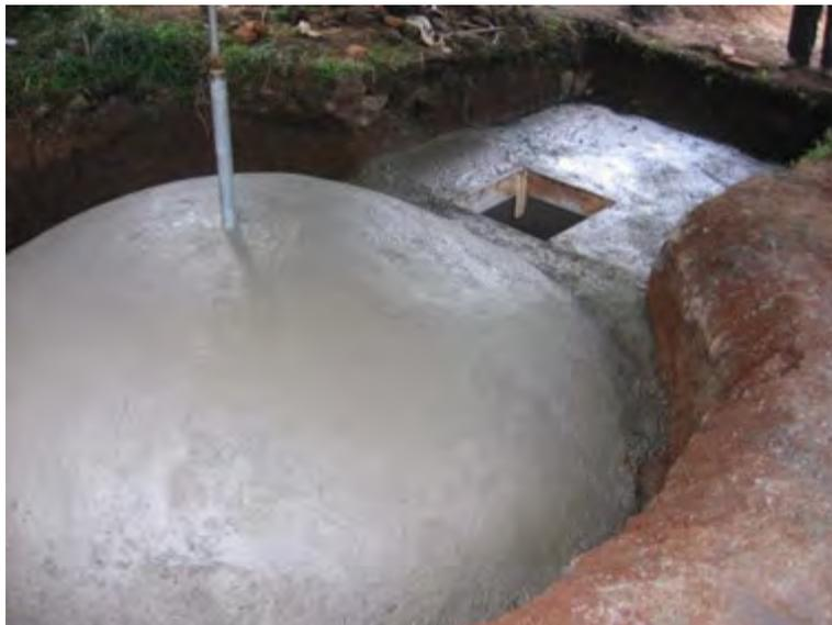
Gambar 96. Permukaan kubah setelah dirapikan
