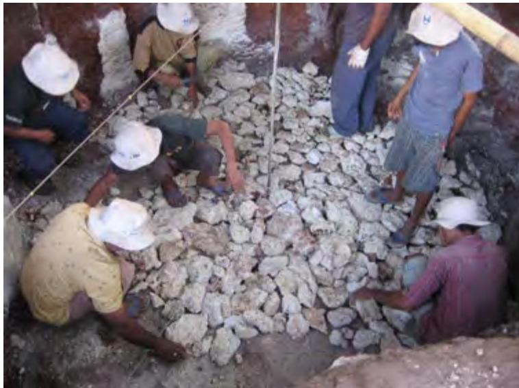
Gambar 50. Lantai kerja yang menggunakan batu kali
