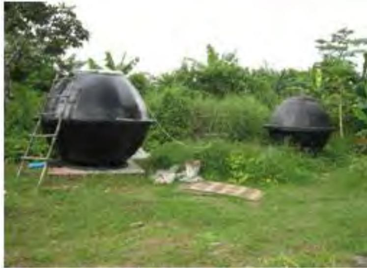
Gambar 30.Reaktor biogas dari bahan *fibre glass*
