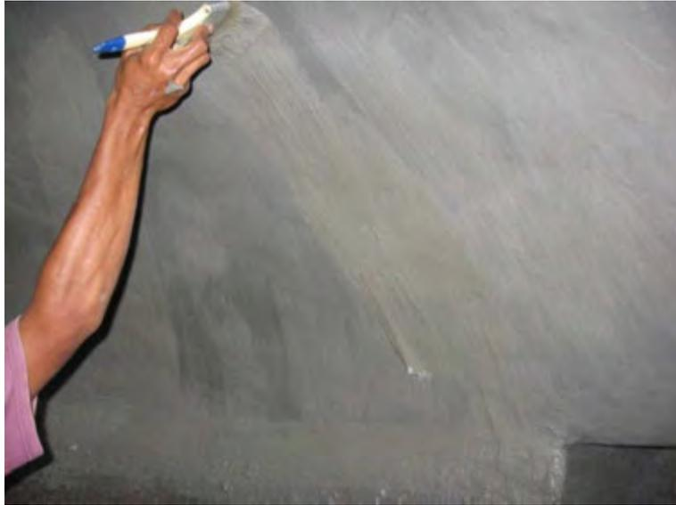
Gambar 178. Gunakan kuas untuk lapisan ke 6
