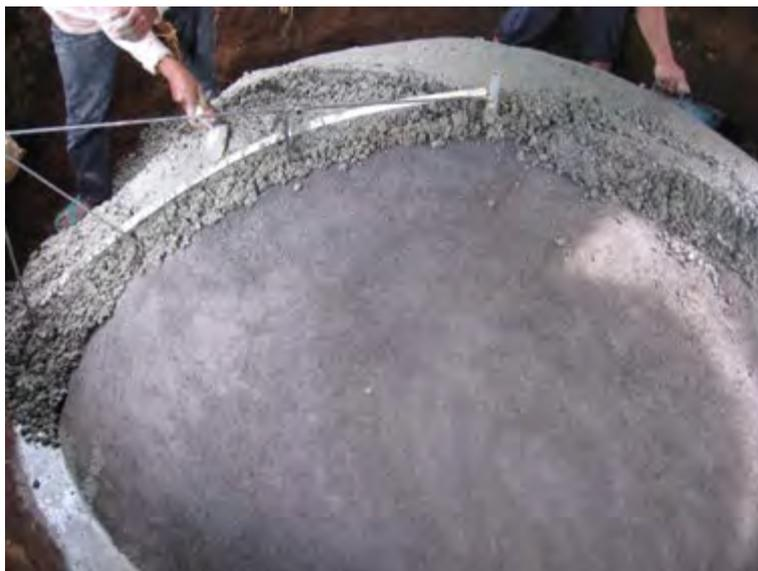
Gambar 92. Pengecoran beton bagian demi bagian
