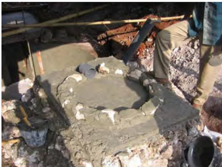
Gambar 136. Memasang batu kali dan pipa saluran
