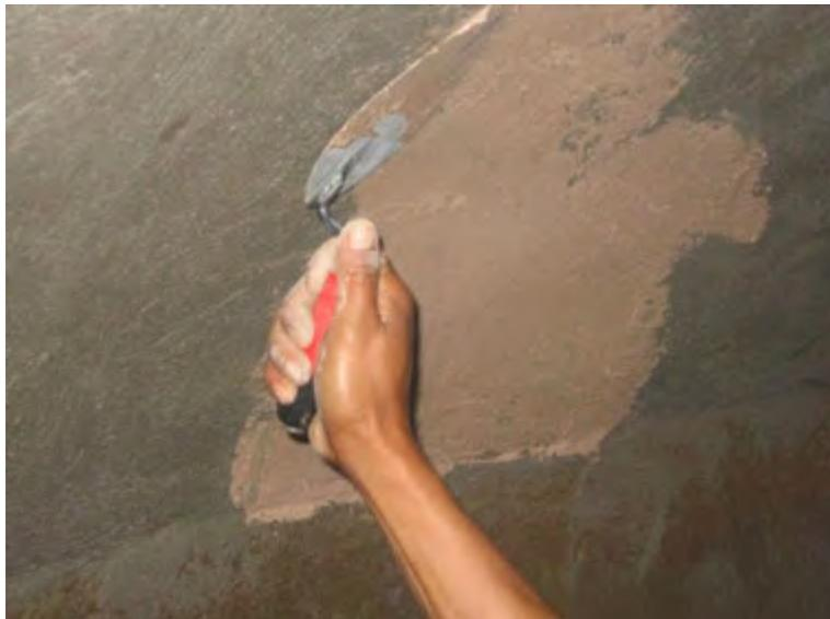
Gambar 177. Gunakan sendok spesi untuk lapisan ke 5
