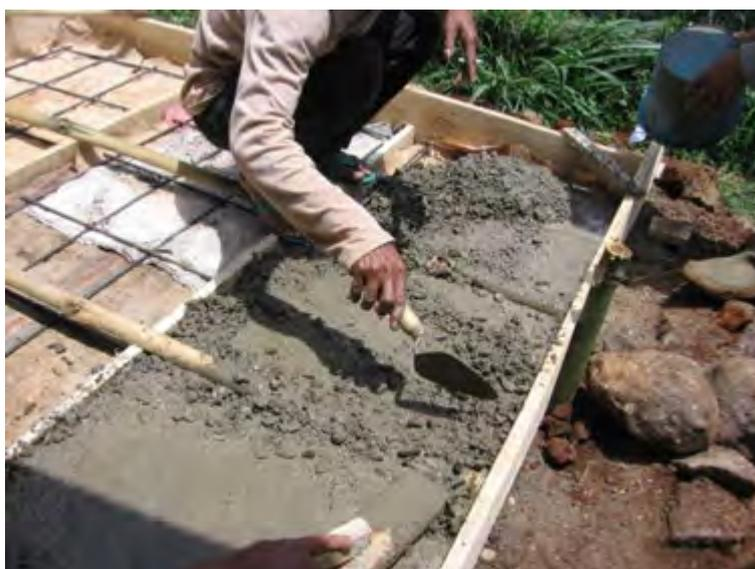
Gambar 102. Pengecoran plat penutup Outlet
