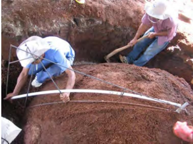
Gambar 85. Pembentukan cetakan kubah dengan mal
