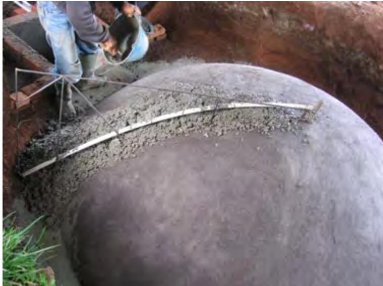
Gambar 91. Mencurahkan adukan beton di bagian atas kubah
