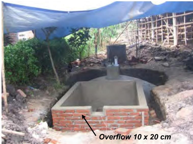
Gambar 120. *Overflow* pada *outlet*
