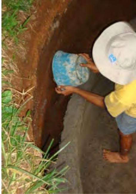
Gambar 69. Pengisian celah dinding tanah dengan tangki pencerna
