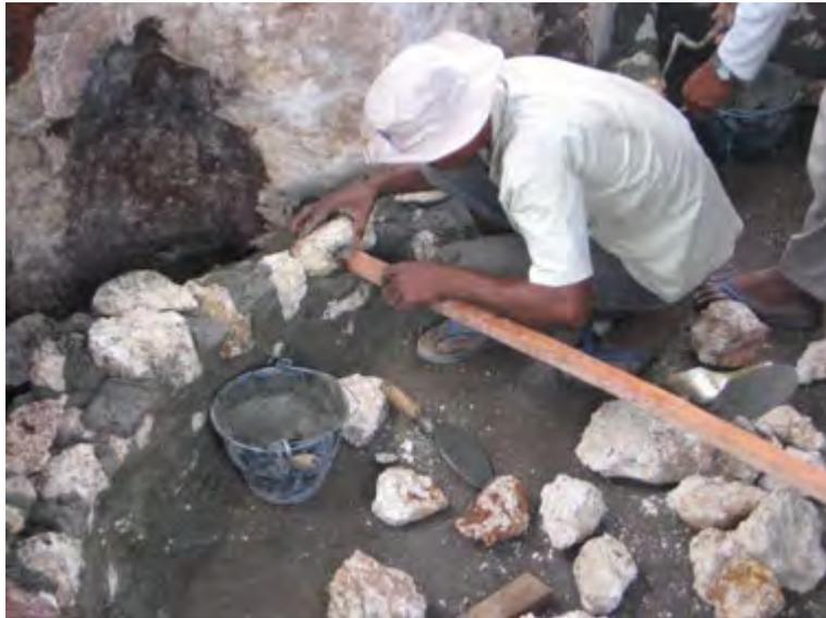
Gambar 77. Dinding tangki pencerna dari pasangan batu kali
