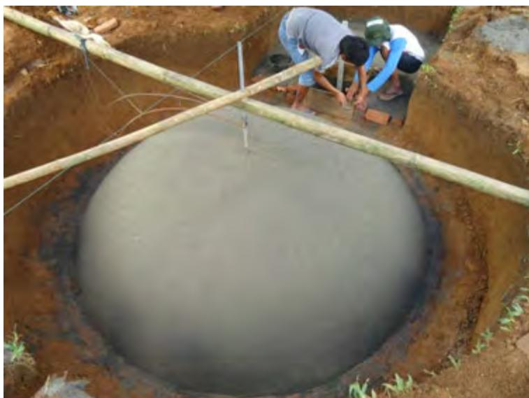
Gambar 88. Cetakan kubah setelah dilapisi pasir
