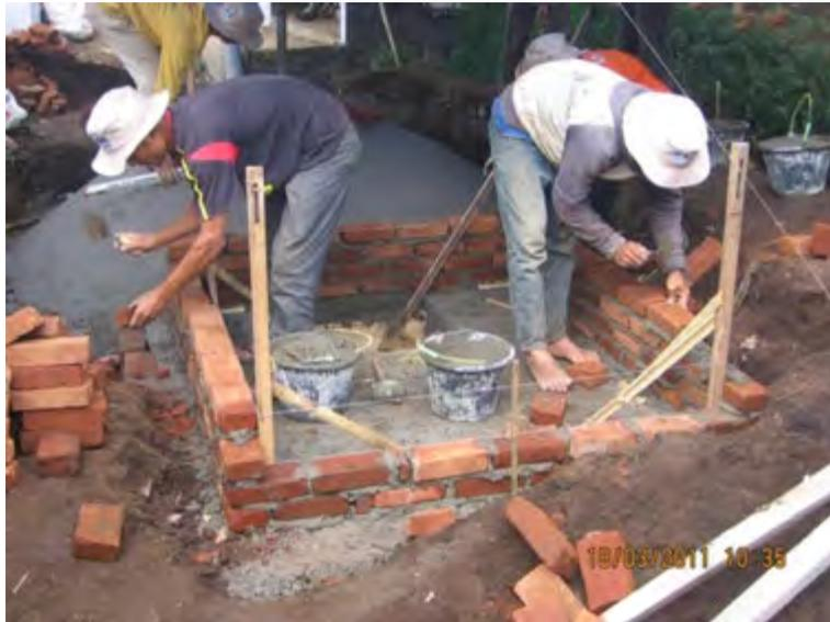
Gambar 118. Pekerjaan pasangan bata dinding *Outlet*
