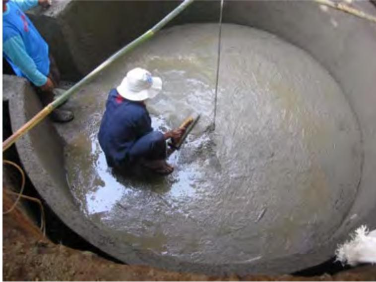
Gambar 71. Pekerjaan *finishing* lantai pondasi
