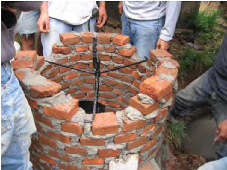
Gambar 131. *Setting out mixer* pada *inlet*
