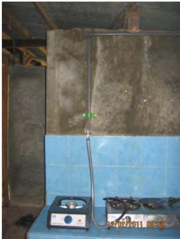
Gambar 165. Contoh instalasi manometer dan kompor
