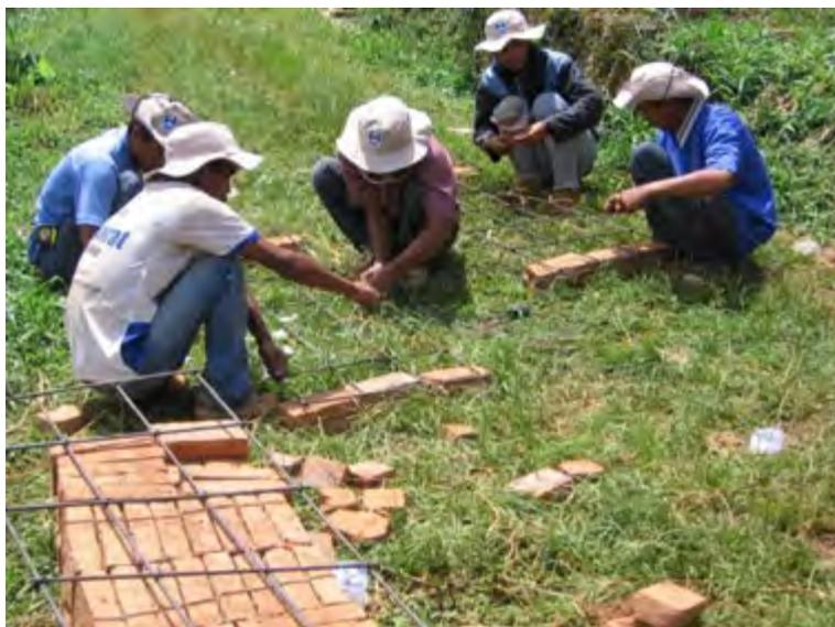
Gambar 100. Pemotongan besi tulangan plat penutup *Outlet*
