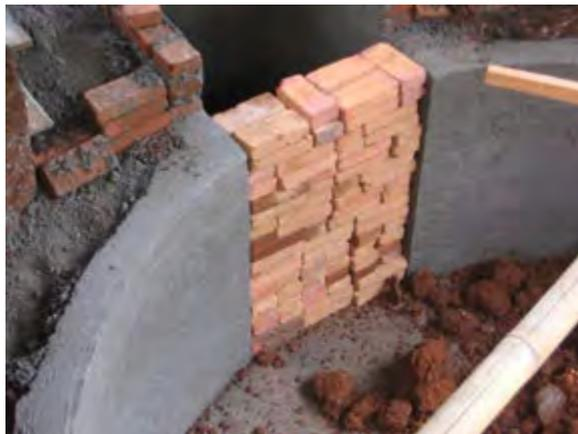
Gambar 82. Pasangan bata pada *Manhole*
