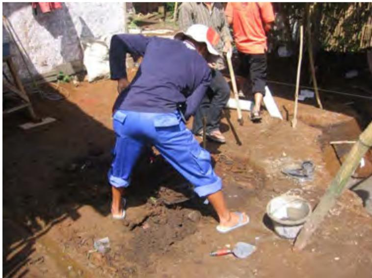
Gambar 125. Menggali tanah untuk menyesuaikan dasar *inlet*
