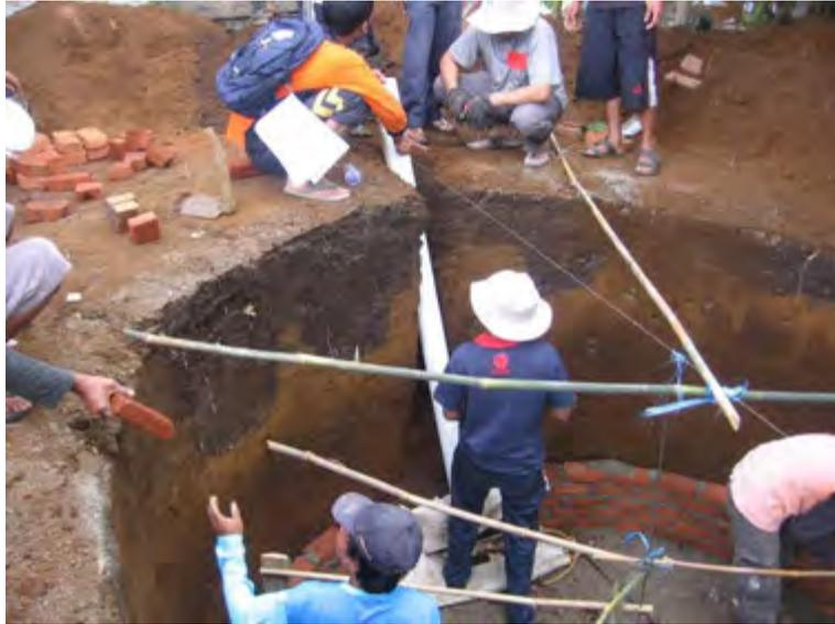
Gambar 63. Penyetelan pipa *Inlet*
