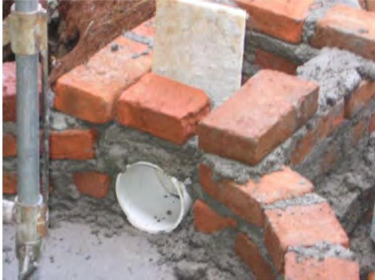
Gambar 130. Memasang kotak pada mulut pipa *inlet*
