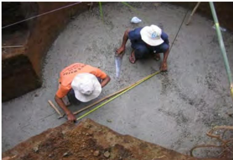
Gambar 54. Menggambar *lay out digester* pada pondasi
