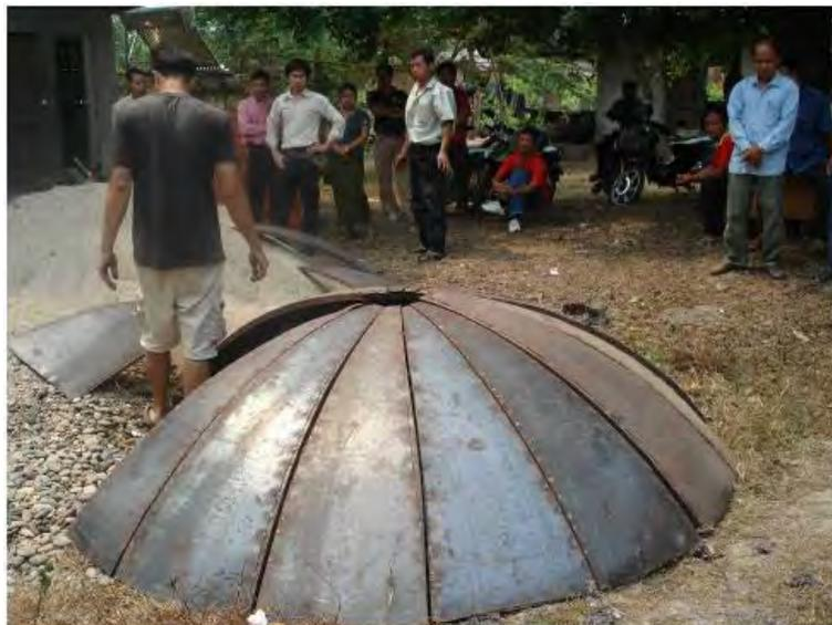
Gambar 79. Contoh cetakan kubah dari plat besi (1)
