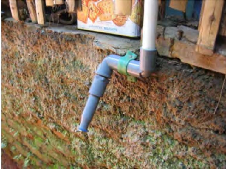
Gambar 148. Pemasangan *water drain* tanpa kotak
