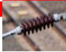
kuat pada atom-atomnya. Bahan-bahan ini dipergunakan dalam alat-alat elektronik sebagai isolator, atau penghambat mengalirnya arus listrik. Isolator berguna pula sebagai penopang beban atau pemisah antara [konduktor](#) tanpa membuat adanya arus mengalir ke luar atau antara konduktor. Istilah ini juga dipergunakan untuk menamai alat yang digunakan untuk menyangga [kabel](#) transmisi listrik pada [tiang listrik](#).
