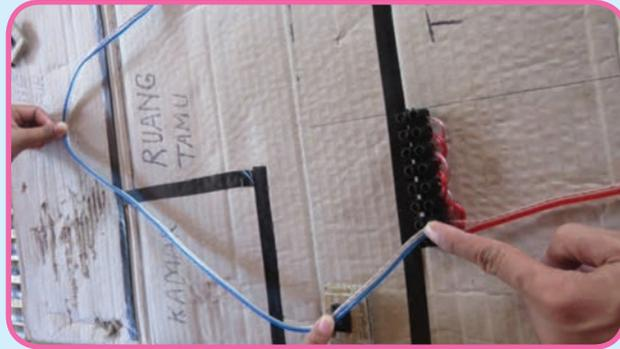
21. Potong kabel biru sesuai jarak sakelar dengan terminal pembagi arus dan pisah dari kabel putih, kemudian pasang kabel biru pada sakelar. (lihat gambar di bawah).
