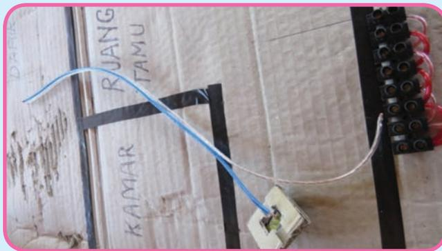
22. Pasang ujung kabel biru yang terpisah ke sakelar dan ujung yang lainnya ke terminal pembagi arus, kencangkan bautnya (lubang nomor 1).
