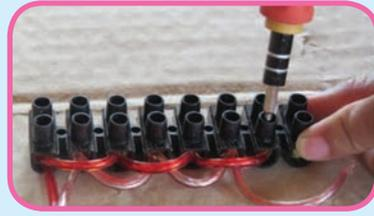
13. Pasang ujung kabel putih di terminal pembagi pada lubang nomor 8.
