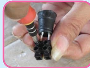
26. Pasang ujung kabel dari sakelar ke terminal sambungan kabel.
